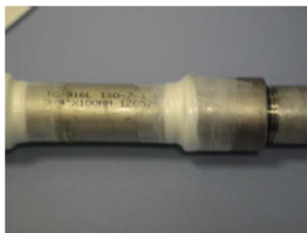
Figure 15 - Colmatage de fuite
