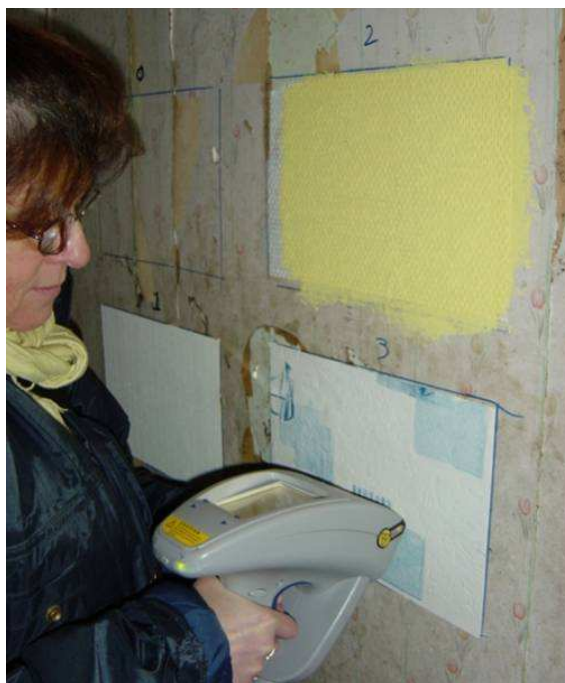
Figure 14 : Zones mesurés sur le mur Diag 6 - Appartement 1 – Mur gauche
