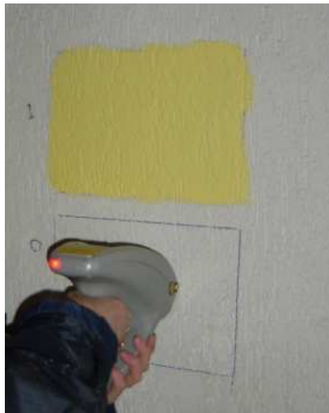
Figure 17 : zones mesurées sur le mur du palier Diag 3 - palier 2 ème étage – Mur
