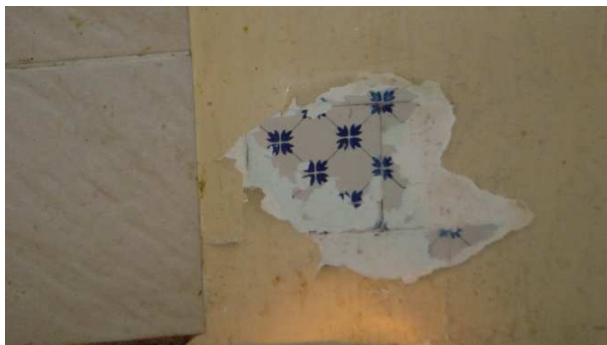
Figure 12 : Zone de mesure sur la faïence Diag 4 - Apart 4 – Mur droit
