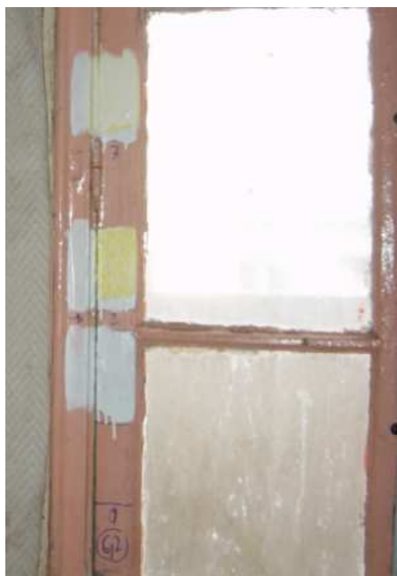
Figure 16 : Zones mesurées sur la fenêtre Diag 3 - Apart 2 – fenêtre
