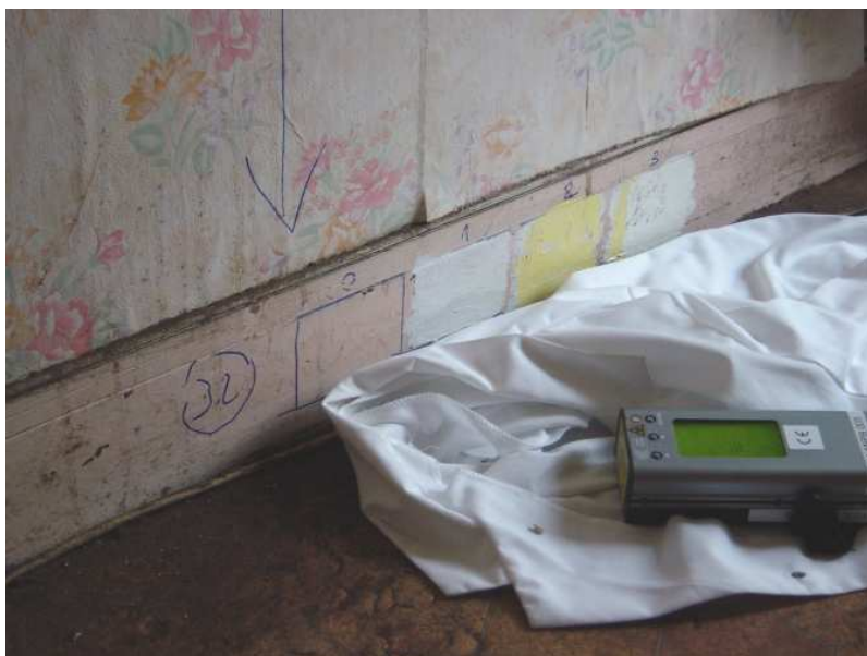
Figure 13 : Zones mesurées sur la plinthe Diag 3 - Appart 2 - Mur G plinthe
