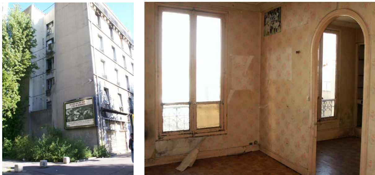
Figure 1 : Site d'étude : vues extérieure et intérieure
