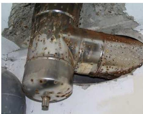
Figure 7 : Exemple de conduit d'évacuation des gaz de combustion corrodé
